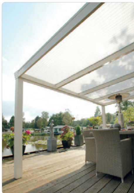
COPERTURA POLICARB Utilizzo lastre alveolari per strutture open air
