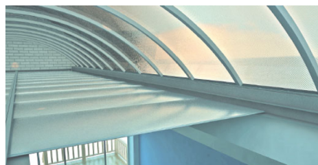
Controsoffitto trasparente sottostante a copertura curva trasparente per massimizzare l'illuminazione naturale
